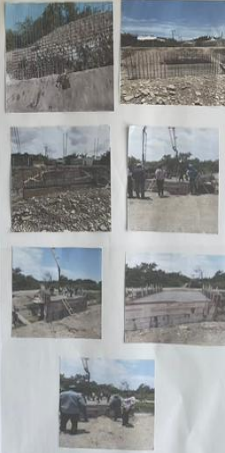
SIGUE LOS TRABAJOS PUENTE ANA LUCILA II.
