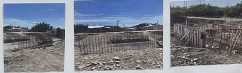
SIGUE LOS TRABAJOS PUENTE ANA LUCIA R.
